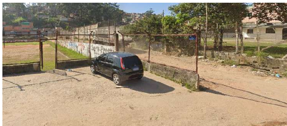
Figura 4 – Vista da lateral esquerda do imóvel usucapiendo.
